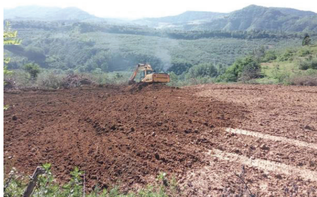
图2 根据坡势地形进行梯改坡整理
