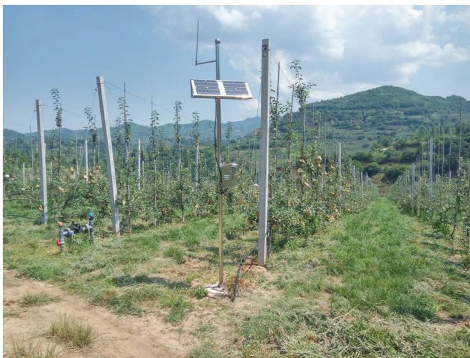
图9 田间水肥一体化滴灌控制设施及树下种草
